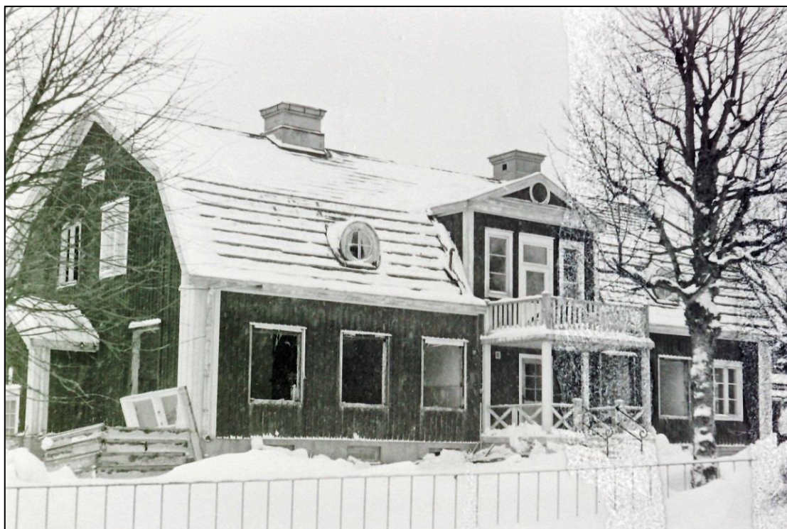
Rivningen har påbörjats av den gamla ålderdomshemsbyggnaden. Okänd fotograf.
